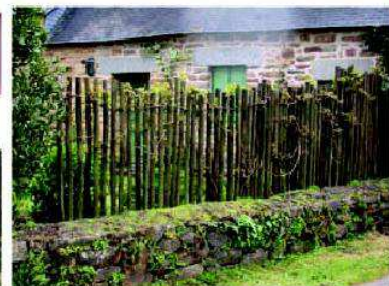
Muret doublé d'une palissade à claire-voie en piquets de châtaignier.
